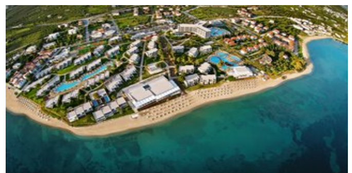
Blick auf die Anlage
