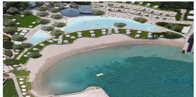
Blick auf die Anlage
