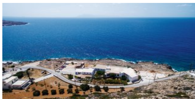
Blick über die Anlage
