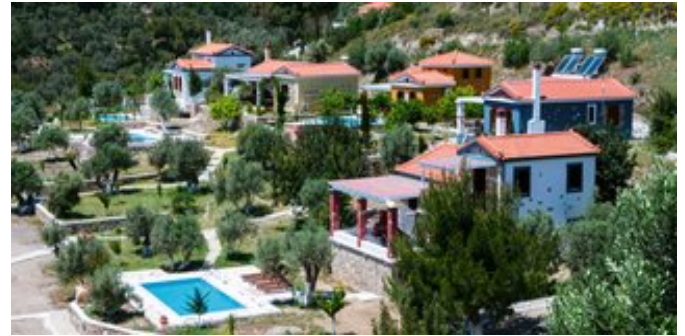
Blick auf die Anlage
