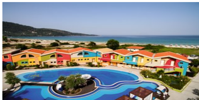
Blick auf die Anlage
