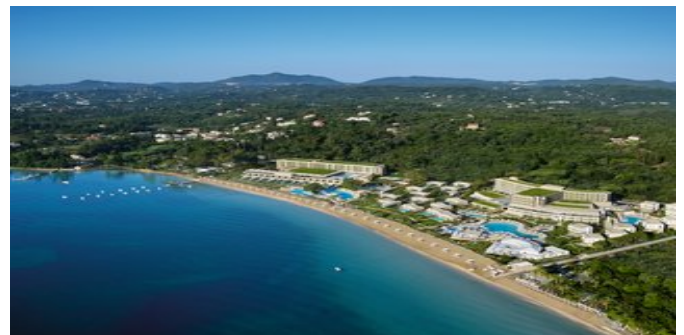
Blick auf die Anlage
