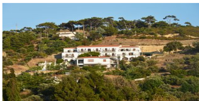
Blick auf die Anlage
