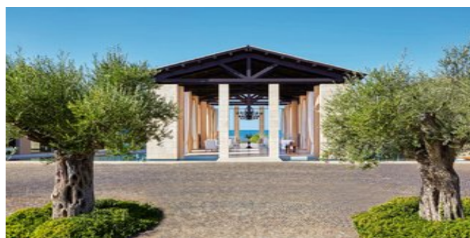
Die Romanos Open-Air Lobby
