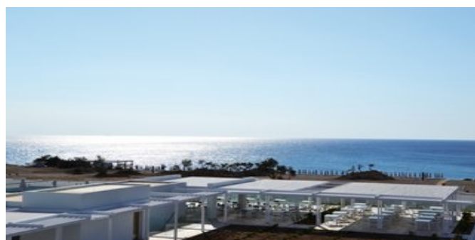
Blick über die Anlage auf das Meer
