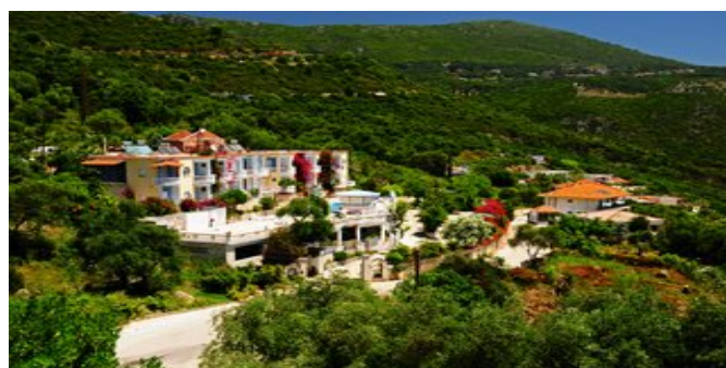
Blick auf die Anlage
