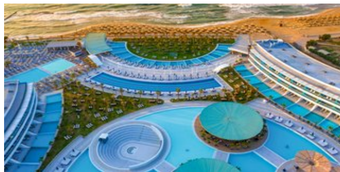
Blick über die Anlage
