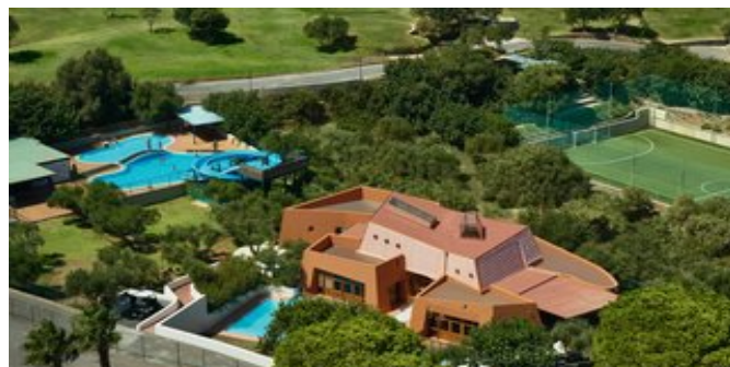
Blick auf einen Teil der Anlage
