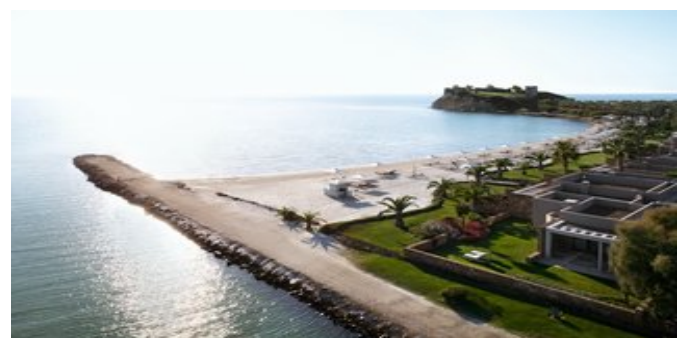
Blick auf die Anlage
