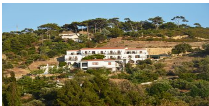
Blick auf die Anlage
