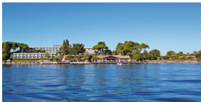
Blick auf die Anlage
