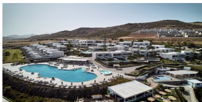
Blick über die Anlage
