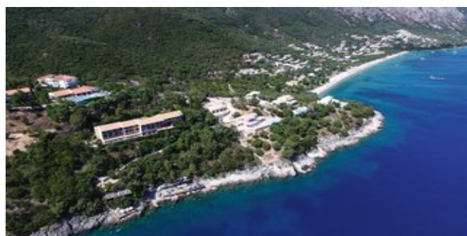
Blick auf die Anlage
