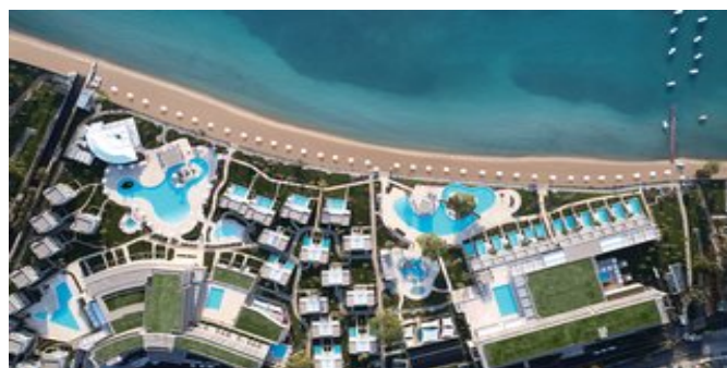
Blick auf die Anlage
