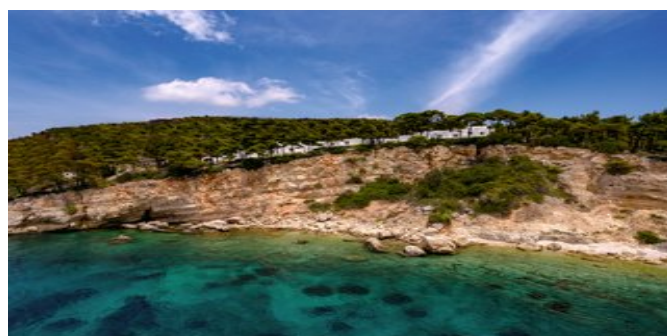
Blick auf die Anlage
