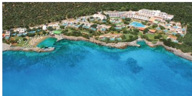
Blick über die Anlage
