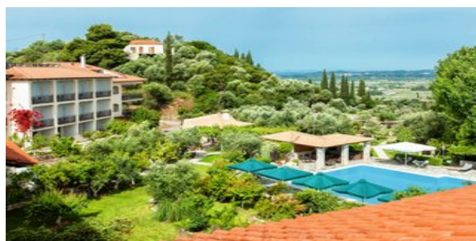
Blick auf die Anlage
