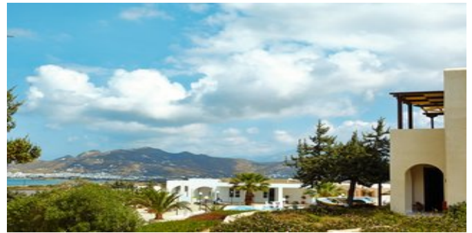
Blick auf die Anlage
