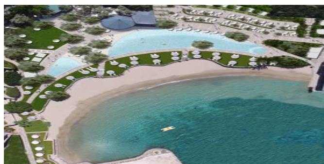
Blick auf die Anlage
