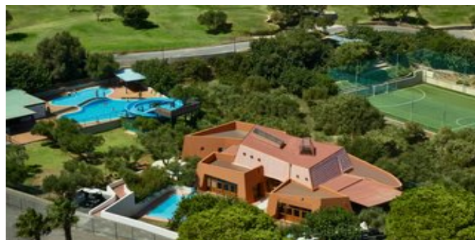
Blick auf einen Teil der Anlage
