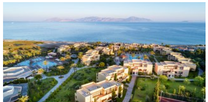
Blick auf die Anlage
