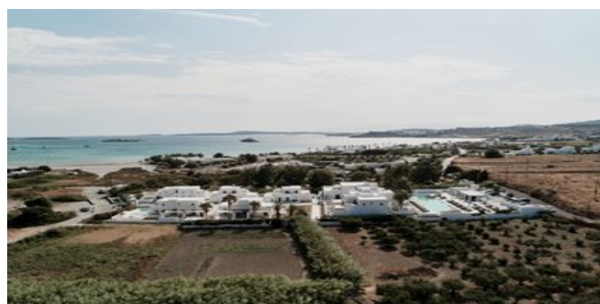
Blick über die Anlage
