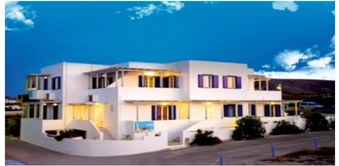
Außenansicht der Sosanna Villa
