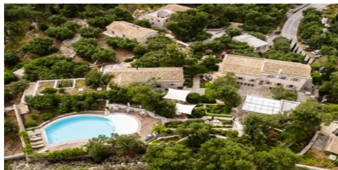
Blick auf die Anlage
