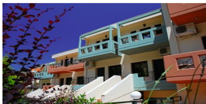
Blick auf die Anlage
