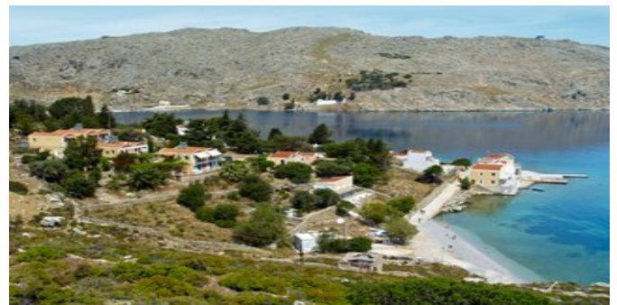
Blick auf die Anlage
