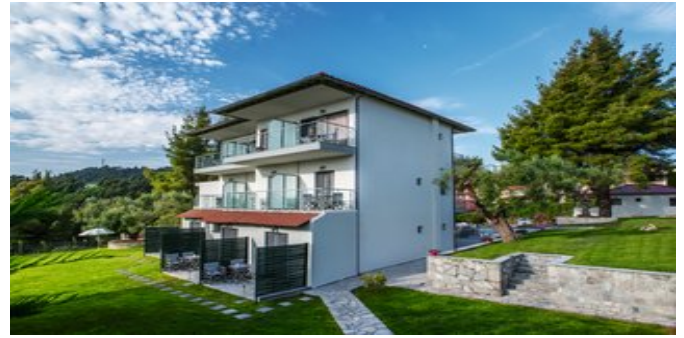
Blick auf die Anlage
