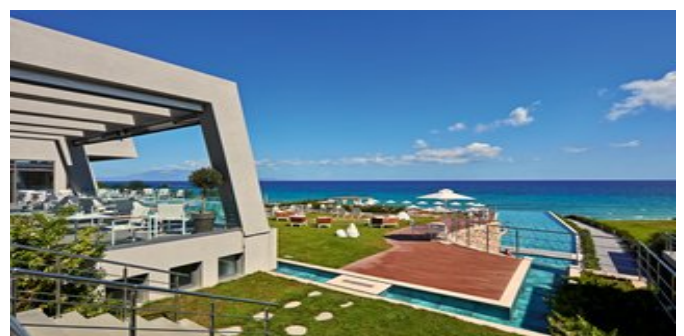
Blick auf die Anlage
