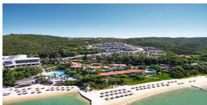
Blick auf die Anlage
