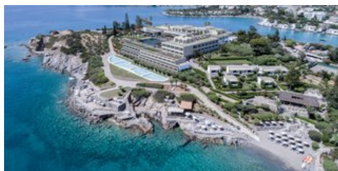
Blick auf die Anlage
