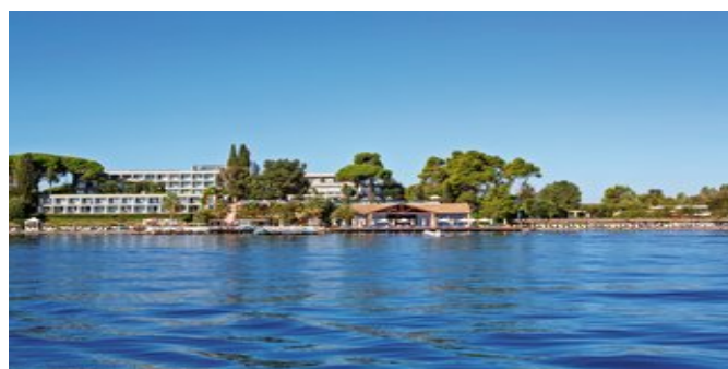
Blick auf die Anlage
