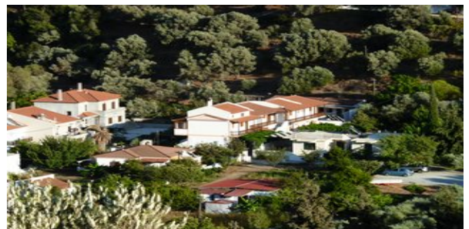
Blick auf die Anlage
