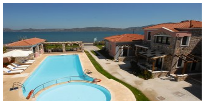
Die Anlage Aeolis
