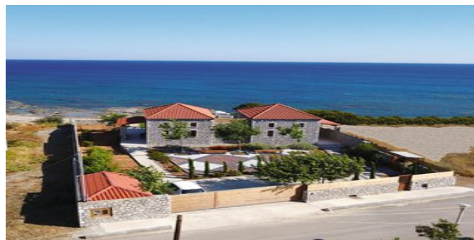
Blick auf die Anlage
