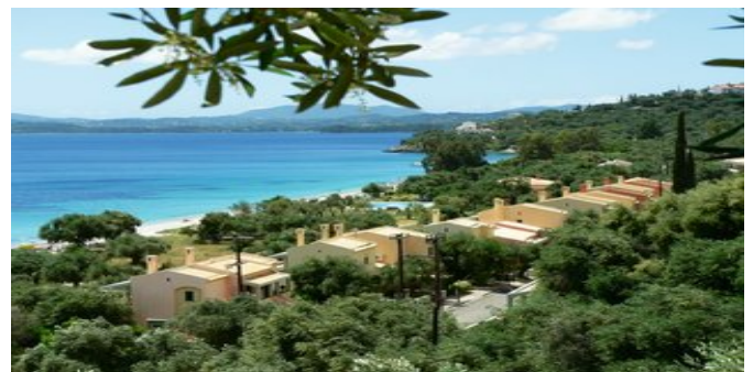
Blick über die Anlage
