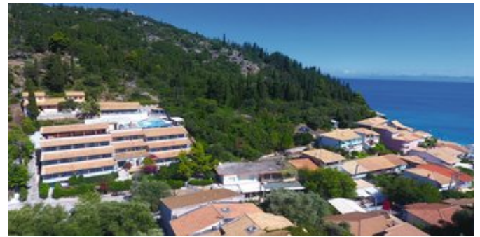
Blick auf die Anlage (links)
