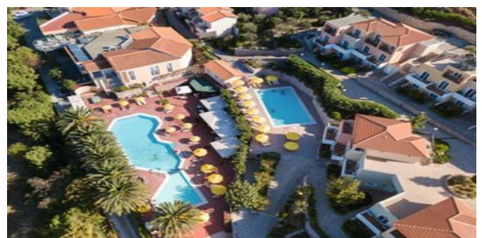
Blick auf die Anlage
