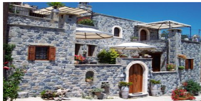
Blick auf die Anlage
