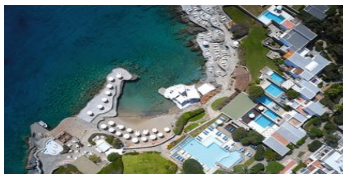
Blick auf die Anlage
