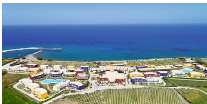
Blick auf die Anlage
