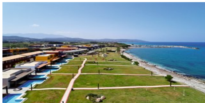
Blick auf die Anlage
