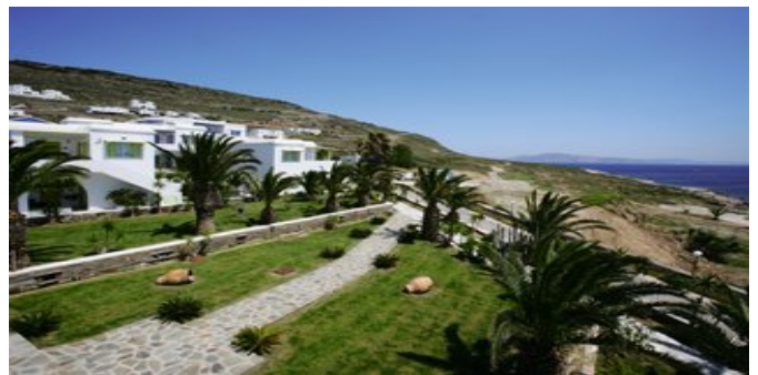
Blick auf die Anlage
