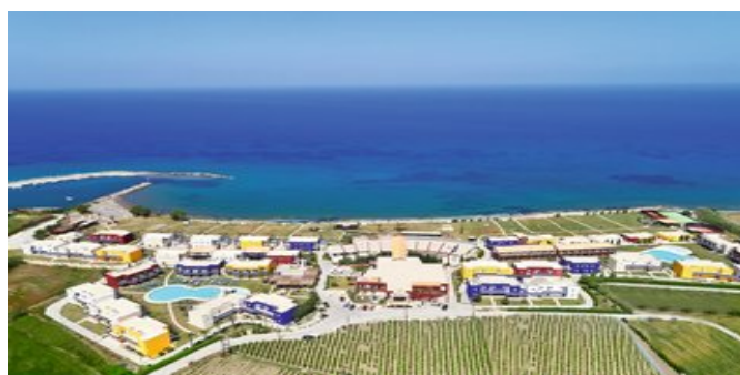
Blick auf die Anlage
