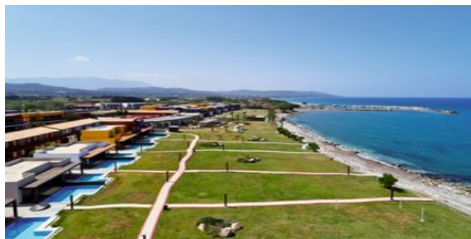
Blick auf die Anlage
