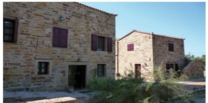
Das Haupt- und Nebengebäude
