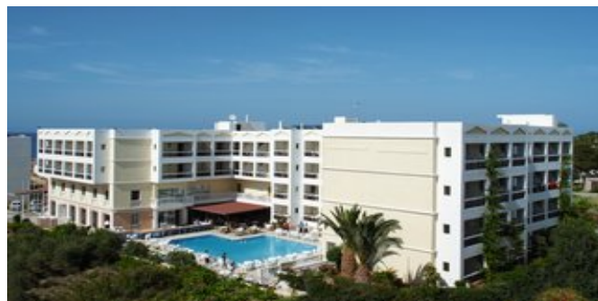
Blick auf die Anlage
