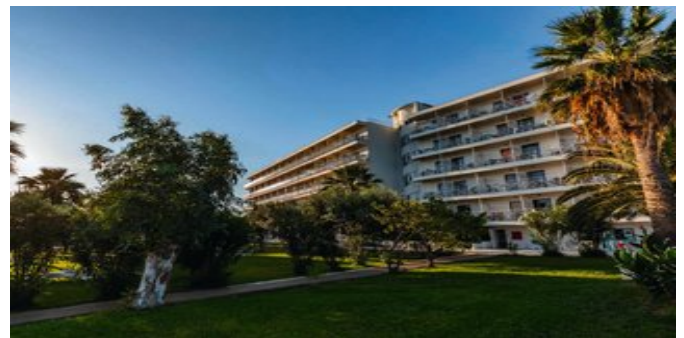
Ein Teil der Anlage
