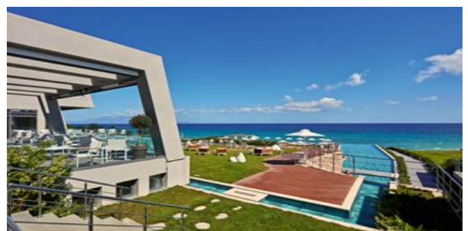
Blick auf die Anlage
