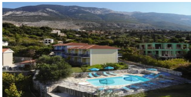
Blick auf die Anlage
